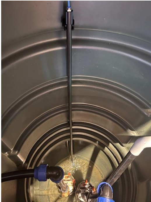
bilden illustrerar placering av luftslang
